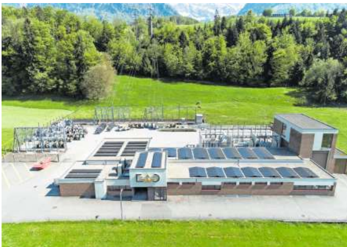
Auf dem Dach des Unterwerks Sarnen produziert das Elektrizitätswerk Obwalden (EWO) Solarstrom. Bild: PD
